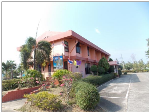
ภายนอกอาคารอำนวยการ
