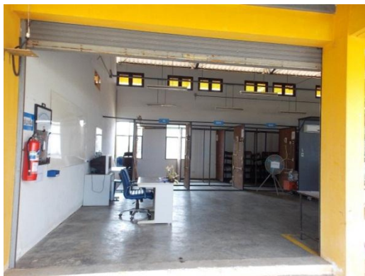
สาขาช่างเดินสายไฟฟ้าภายในอาคาร
