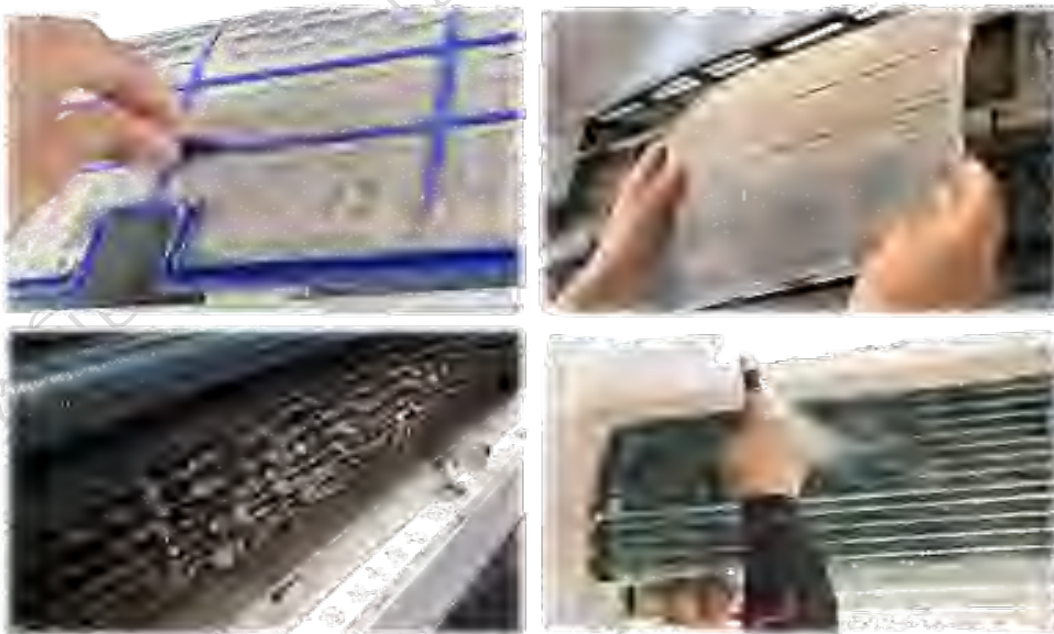
ภาพที่ 513 ถอดอุปกรณ์เครื่องตัวในและล้างด้วยเครื่องแรงดันน้ำสูง
