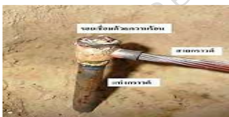
ก. การเชื่อมบัดกรี หรือการต่อเชื่อมด้วยความร้อน
