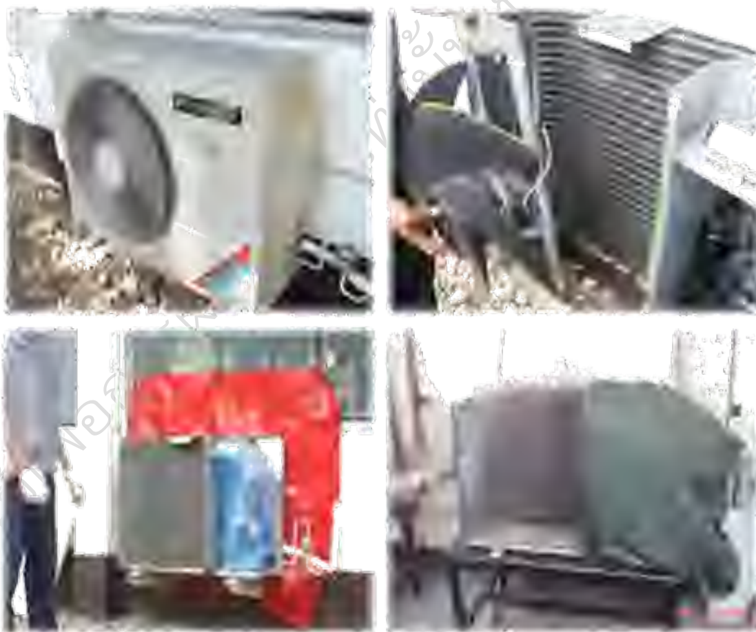
ภาพที่ 515 ถอดอุปกรณ์เครื่องตัวนอกและล้างด้วยเครื่องแรงดันน้ำสูง
