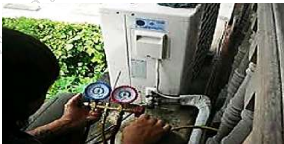
ภาพที่ 502 เติมน้ำยาเข้าระบบ
