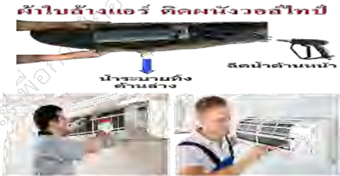
ภาพที่ 514 คลอบด้วยผ้าใบล่างเครื่องปรับอากาศและฉีดน้ำทำความสะอาดฟินคอยล์
