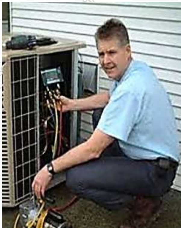
ภาพที่ 503 เดินเครื่องทดสอบ
