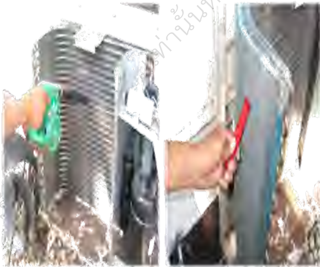
ภาพที่ 516 เป่าด้วย brower ให้แห้ง แล้วแต่งคอยล์ร้อนด้วยหวีแต่งฟินคอยล์
