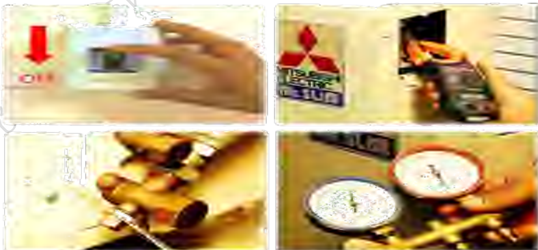
ภาพที่ 512 ก่อนล้างต้องทดสอบเครื่องฯและทำการจดบันทึกข้อมูลต่างๆ
