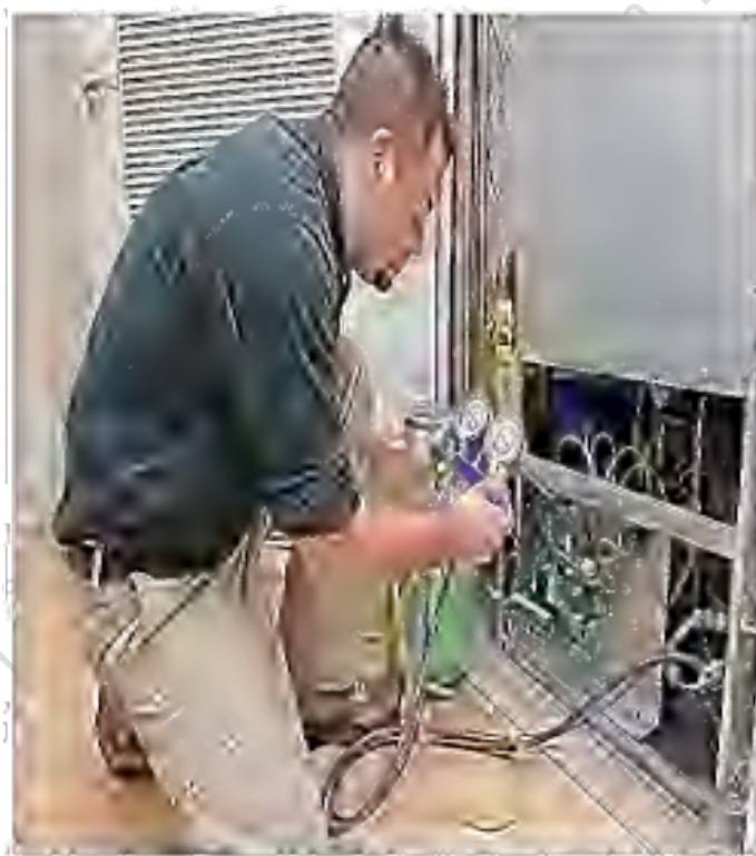
ภาพที่ 255 ตัวอย่างการเติมสารทำความเย็นเข้าระบบ
