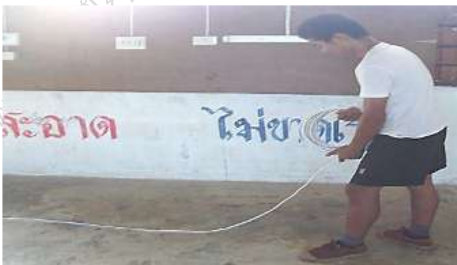
ภาพที่ 150 แสดงการคลี่สายไฟฟ้าและรัดสายไฟฟ้า
