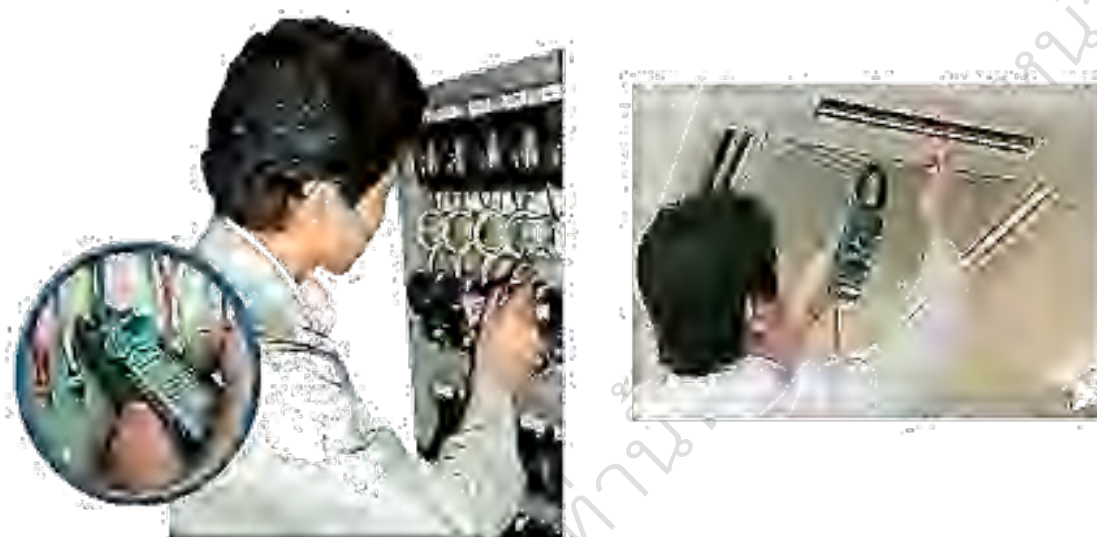
ภาพที่ 228 ตัวอย่างการนำแคลมป์มิเตอร์ไปใช้งานด้านต่างๆ
