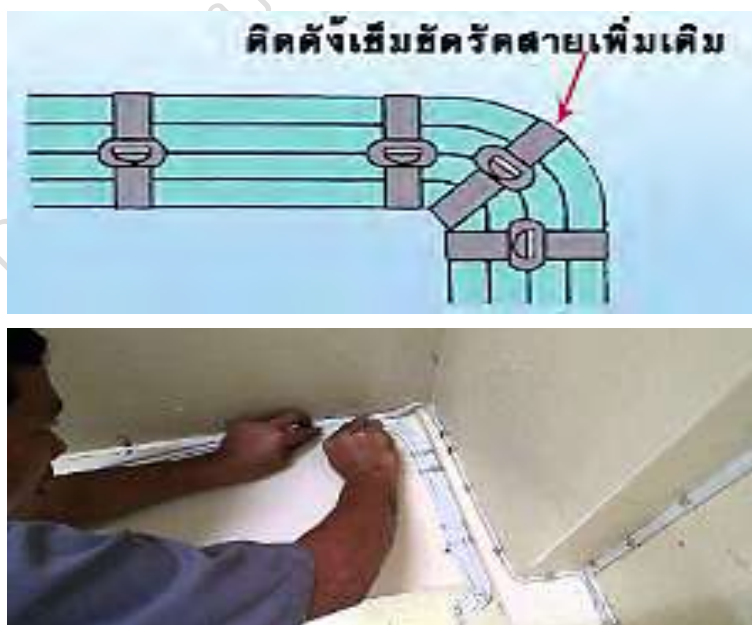
ภาพที่ 155 แสดงการเดินสายไฟฟ้าหักมุมโค้งหลายเส้น
