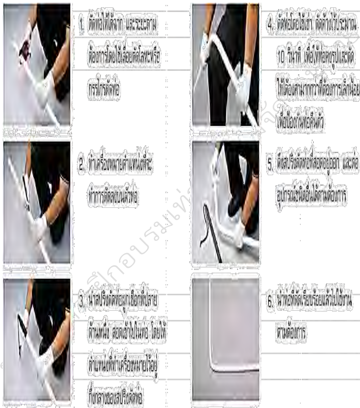
ภาพที่ 167 แสดงการตัดท่อ PVC ด้วยสปริงตัดท่อ 90 องศา
