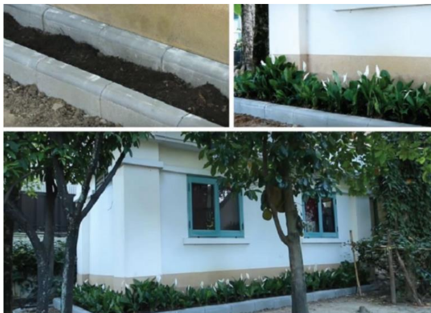
รูปที่ 14 ภาพการปิดโพรงใต้อาคารด้วยการปรับภูมิทัศน์ด้วยขอบคั่นหิน
