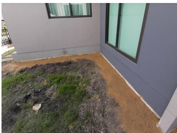
รูปที่ 13 การปิดโพรงใต้อาคารระบบ SMART SPACE COVERING และเสริมด้วยตกแต่งภูมิทัศน์
