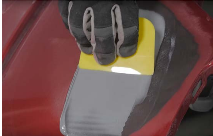
รูปที่ 7 การซีลเลอร์ (โป้ว) พื้นผิว
