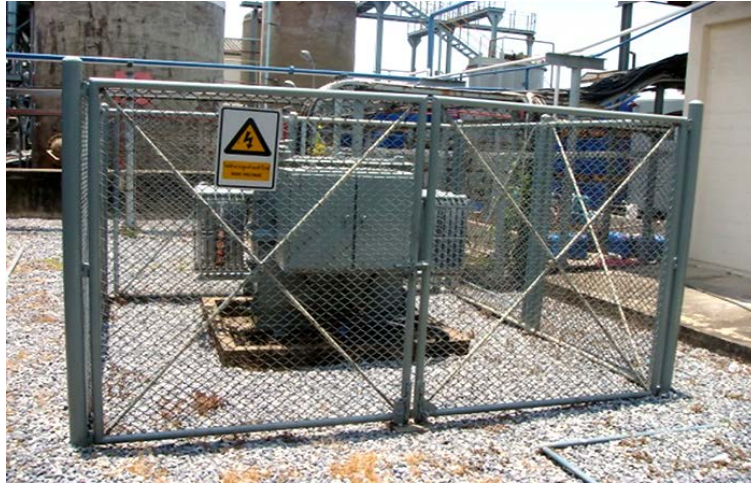
รูปที่ 12.1 ลานหม้อแปลงมีการโรยหิน มีรั้วกั้นบริเวณอันตราย มีป้ายเตือน
