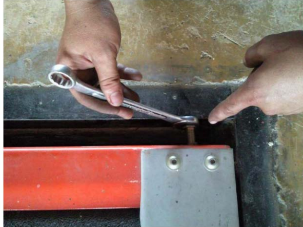
รูปที่ 4 การตรวจสอบระยะความห่างระหว่างเครื่องกับโครงหลุม
