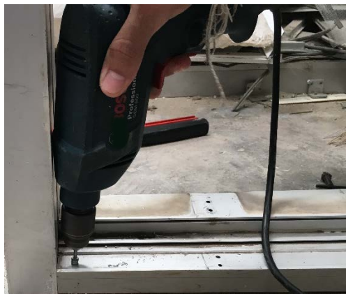
รูปที่ 6.14 แสดงการใช้งานสว่านไฟฟ้าชนิดธรรมดา (ที่มา : https://realmartonline.com/ )
