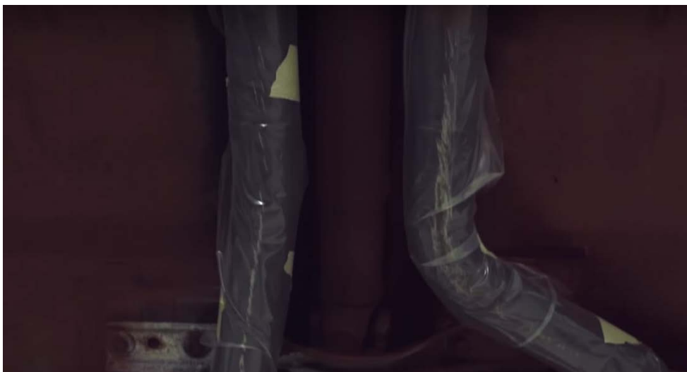
รูปที่ 12 วิธีการติดกระดาษสำหรับแอนเดอร์โค้ด
