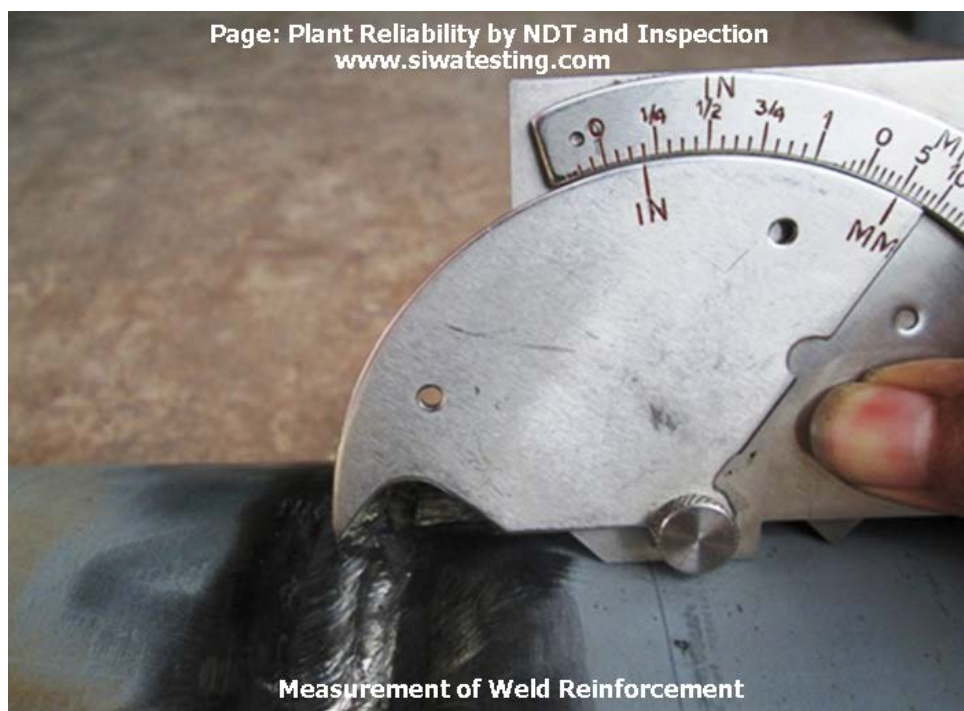
รูปที่ 12.19 ตัวอย่างการตรวจพินิจรอยเชื่อม ทำการวัดความนูนของรอยเชื่อมด้วยเกจวัดรอยเชื่อม (Measurement of weld reinforcement by a welding gage)
