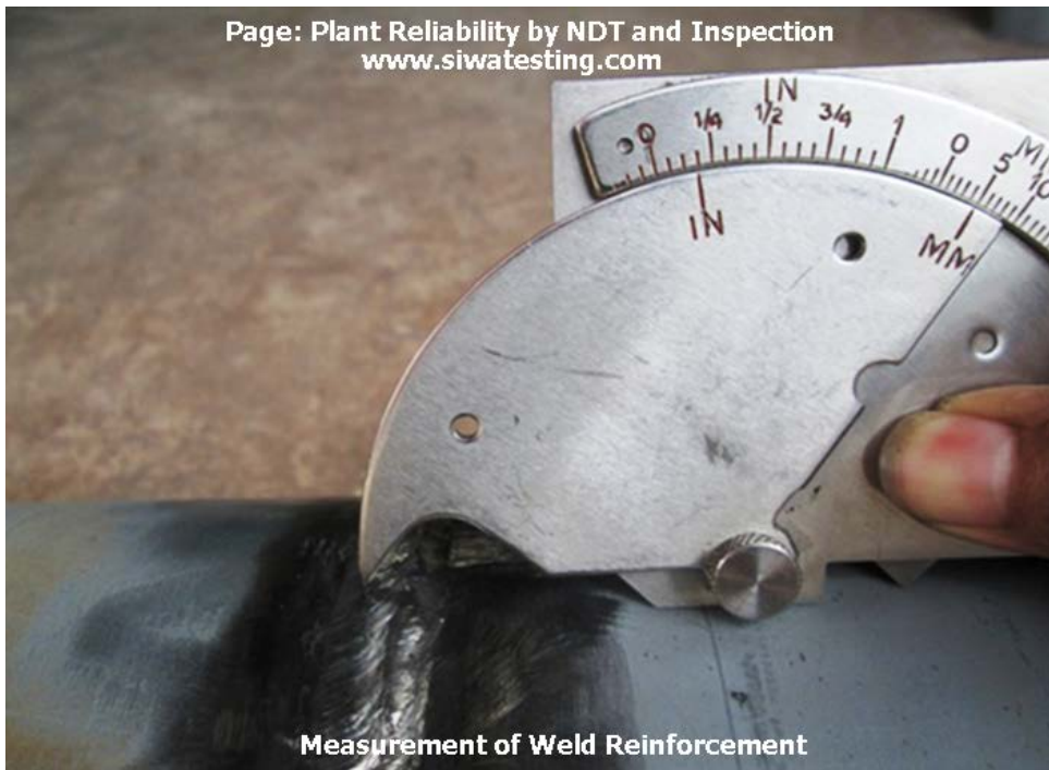
รูปที่ 9.19 ตัวอย่างการตรวจพินิจรอยเชื่อม ทำการวัดความหนาของรอยเชื่อมด้วยเกจวัดรอยเชื่อม (Measurement of weld reinforcement by a welding gage)
