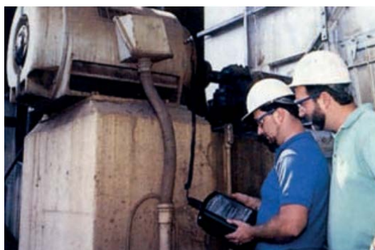
รูปที่ 1 การตรวจสอบมอเตอร์
