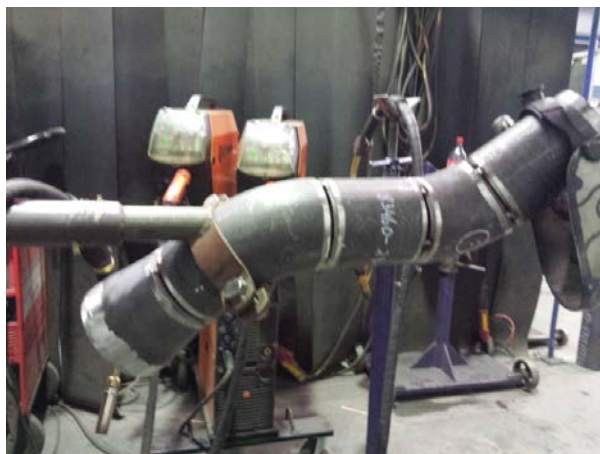
รูปที่ 1 แสดงการใช้อุปกรณ์จับยึดประกอบท่อให้ได้มุมที่ต้องการ
