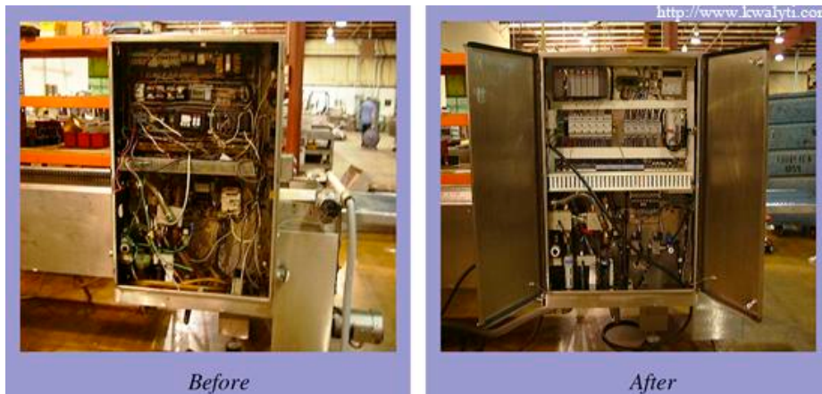
รูปเปรียบเทียบการควบคุมแบบรีเลย์ และ PLC
