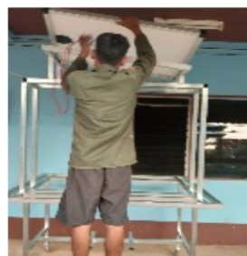
ประกอบโครงสร้างติดตั้งแผงเซลล์แสงอาทิตย์
