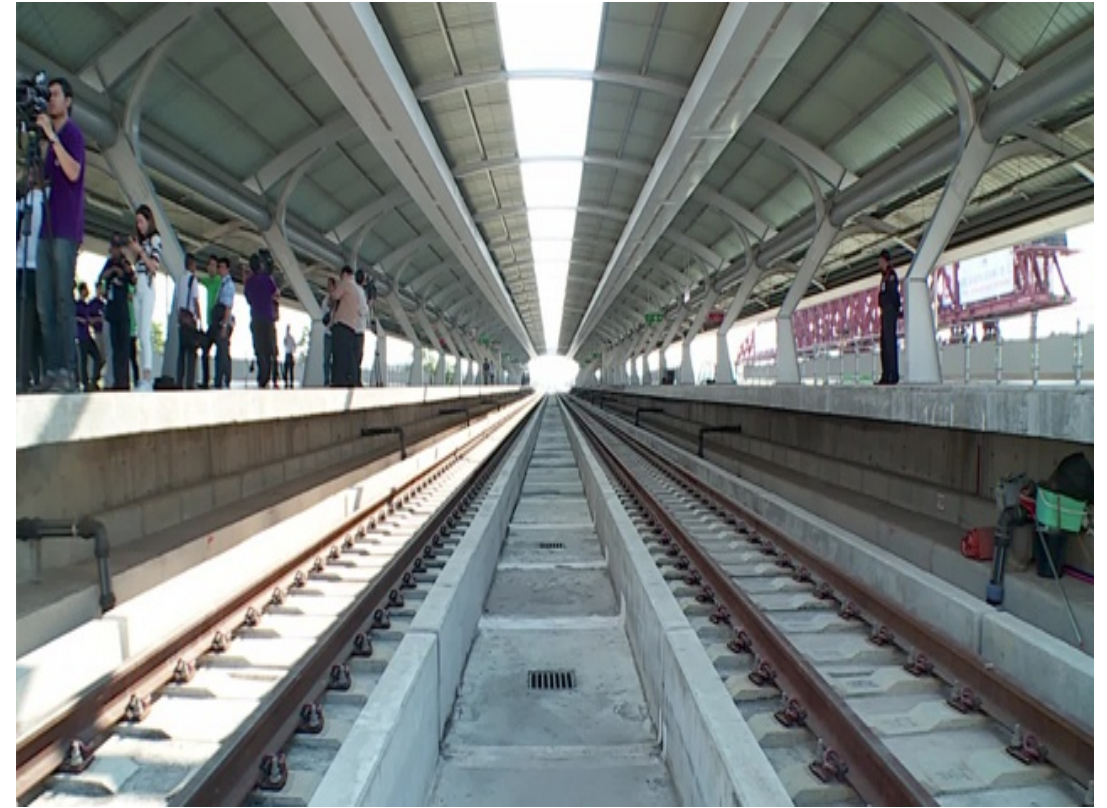
2) ชั้นรองรับรางแบบไม่ใช้หินโรยทาง (Ballast less /Slab Track)
