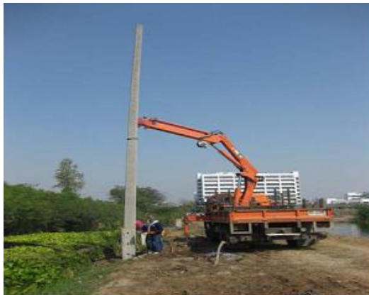
รูปที่ ๒.๒๓ การใช้รถปักเสาไฟฟ้า
