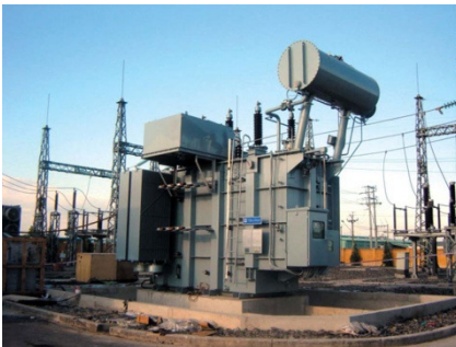
รูปที่ ๒.๓๖ การติดตั้งหม้อแปลงแบบตั้งพื้น
