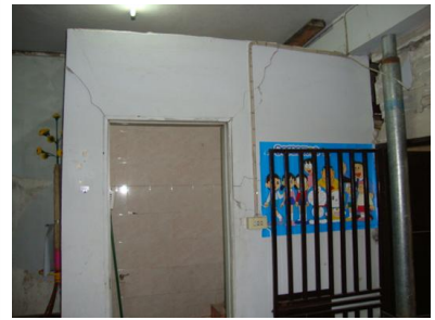
การแตกร้าวของผนังที่กั้นห้องโดยไม่มีเสา
