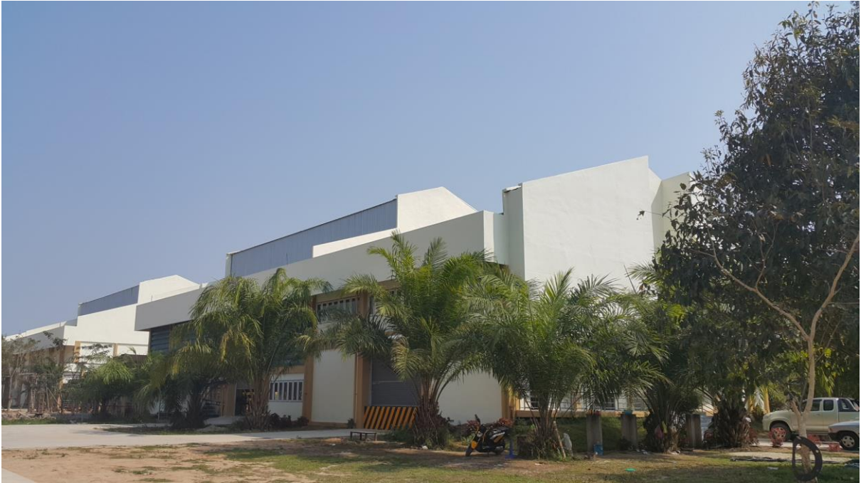
(๓) อาคารฝึกอบรมช่างซ่อมบำรุง ๒ (Maintenance Building ๒)
